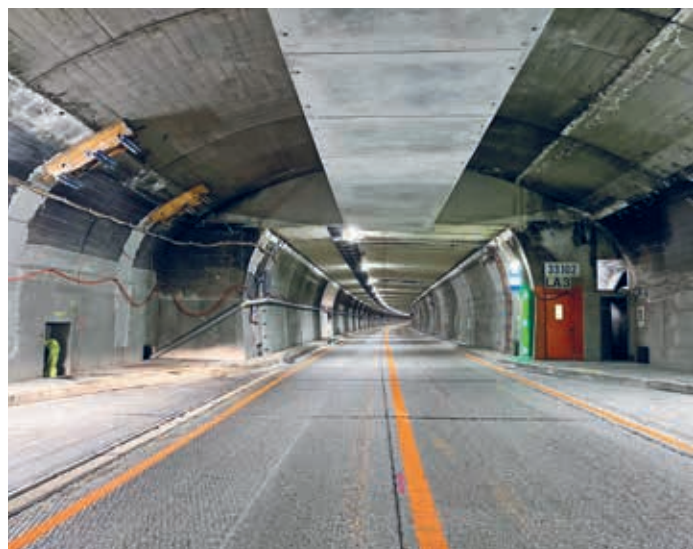
Ruhe vor dem Sturm: Kurz vor Arbeitsbeginn ist der Giessbachtunnel verkehrsfrei.
