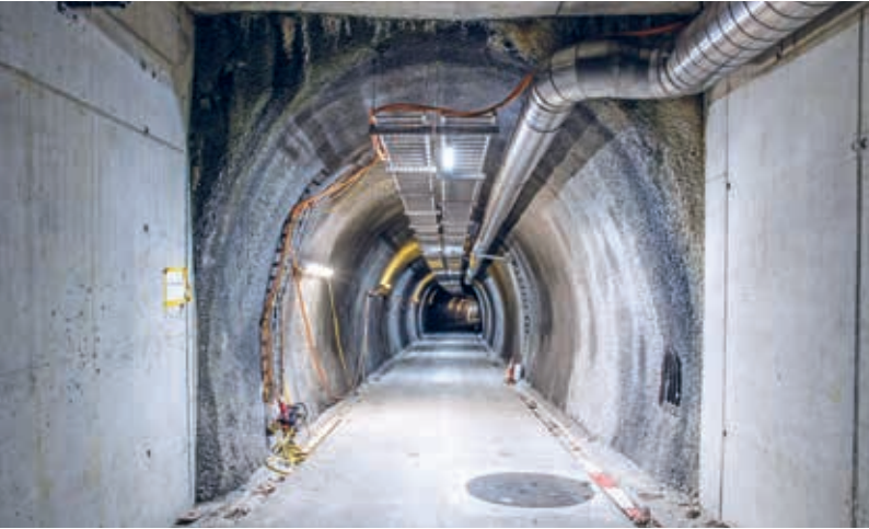
Der Sicherheitsstollen ist baulich fertiggestellt, aber noch nicht fertig ausgerüstet.
