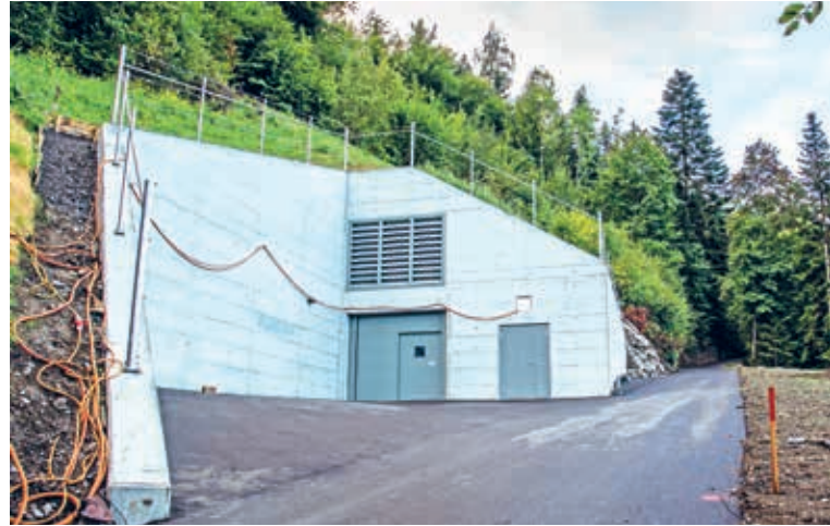
Das Ostportal des Stollens liegt an einer Waldstrasse auf der Ostseite von Leissigen.
