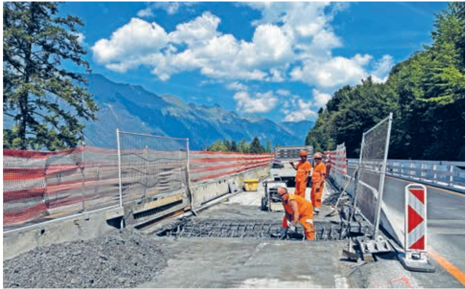
Vorbereitungsarbeiten für den Einbau eines neuen Fahrbahnübergangs an einer Brücke bei Erschwanden.
