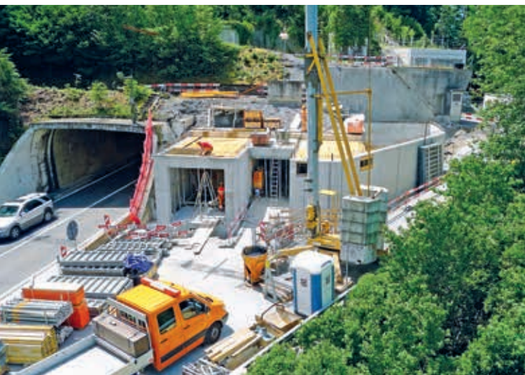
Erweiterung Tunnelzentrale Giessbach Ost
