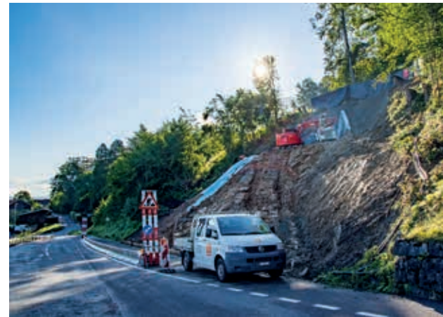
Hier an der Krattigstrasse bei Leissigen entsteht das künftige Westportal des Sicherheitsstollens.
