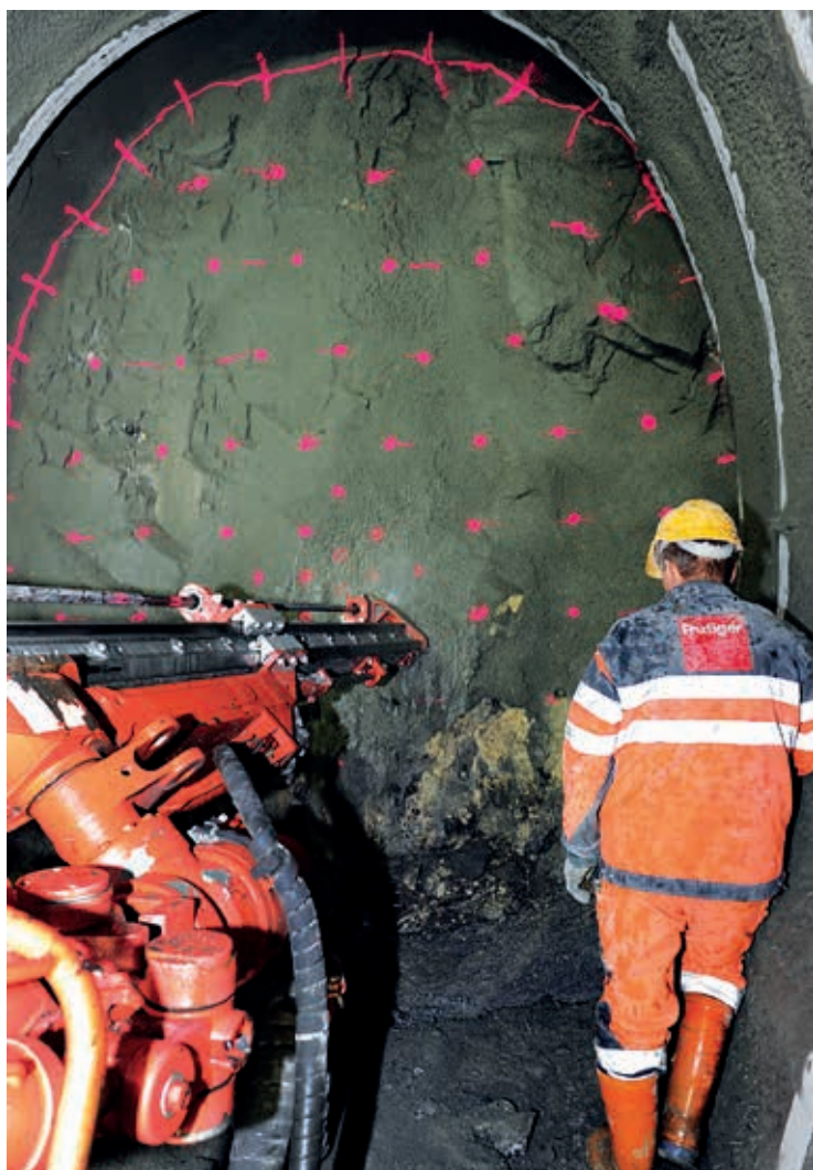
Der letzte Abschnitt des Giessbach-Sicherheitsstollens wird im Sprengvortrieb ausgebrochen: Für die Sprengladungen werden Löcher gebohrt.
