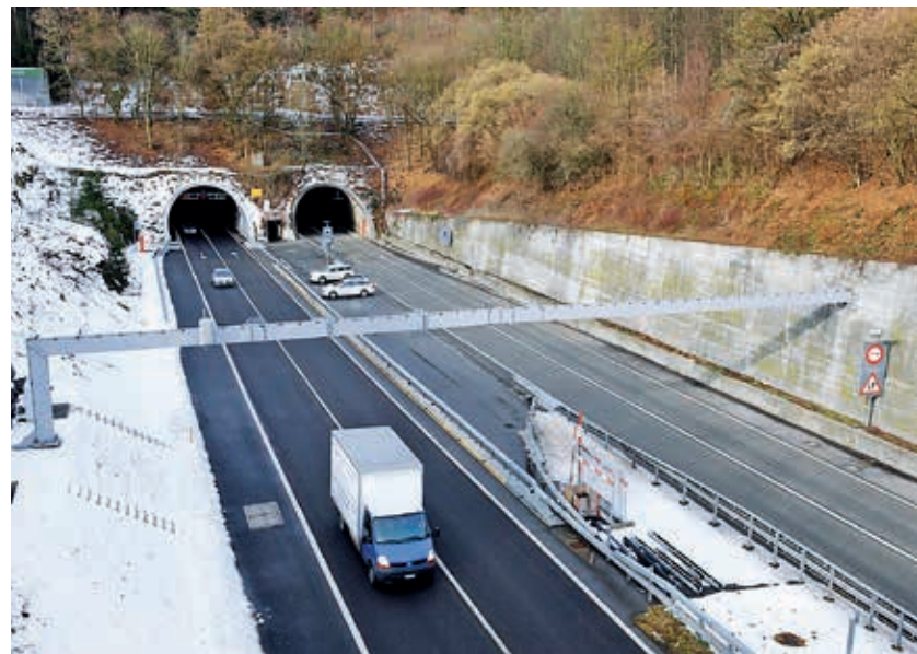
Links fertig, rechts noch nicht: Beim Rugentunnel ist die Südröhre saniert, nun folgen die Nordröhre und die Stützmauer Unspunnen.
